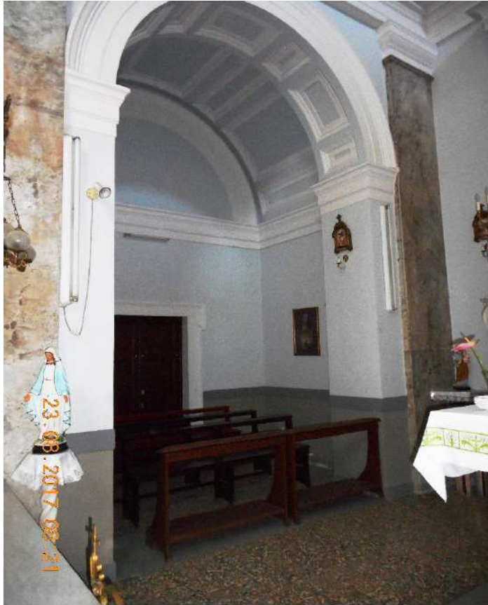
ARCATA LATERALE SINISTRA CON ACCESSO ALLA SALA MORTUARIA
